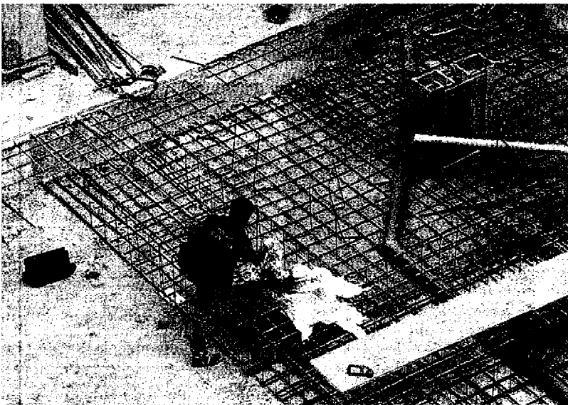
L'armatura in ferro su cui è caduto Daniele Guidarini
