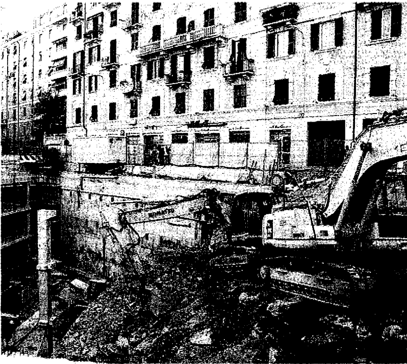
Lo scavo per la realizzazione dell'autosilo in piazza Merani, ad Albaro
