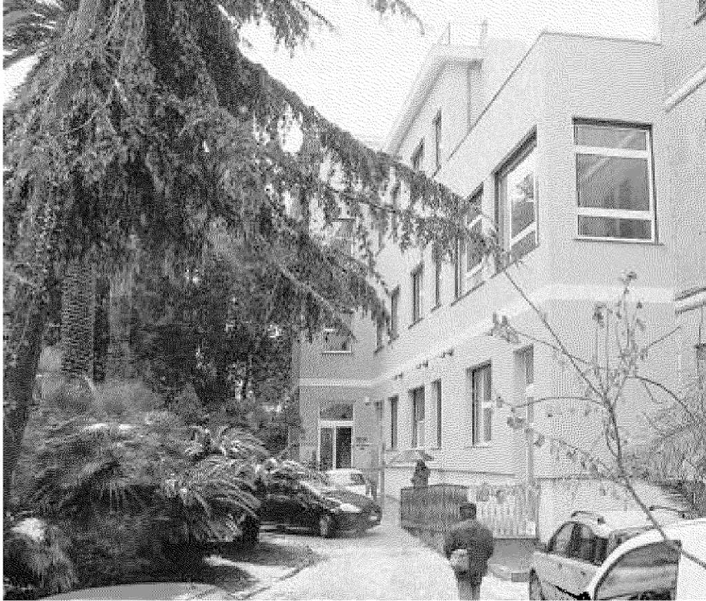
La Casa della salute, a Villa De Mari, inaugurata il mese scorso a Genova Pra' dopo 7 mesi di lavori
